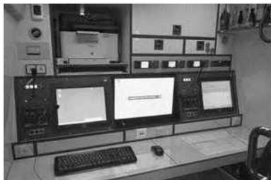
Die Funkarbeitsplätze verfügen über modernste Technik. So ist die Bedienung von Digitalfunk, Analogfunk und Telefon über jeweils einen PC möglich, das Hantieren mit mehreren Telefonhörern bzw. Funkmikrofonen entfällt, es wird einfach per Mausklick die jeweilige Quelle auf das Headset des Funkers geschaltet.
